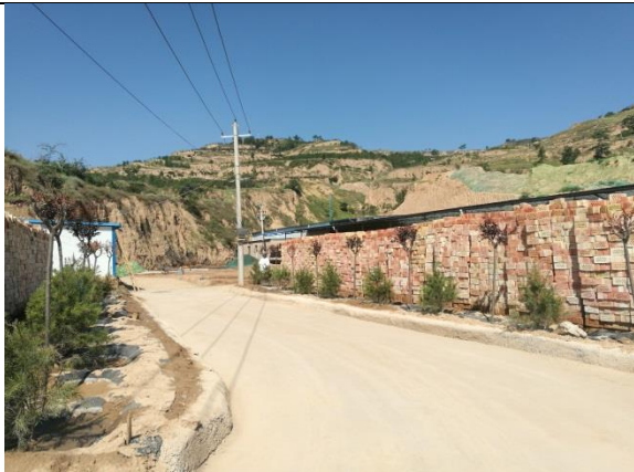
厂区道路硬化
